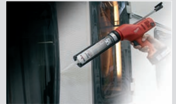
Abdichten von Fenstern
