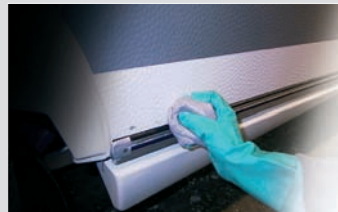
Überschüssiges Material kann einfach mit gleichem Material abgetupft werden
